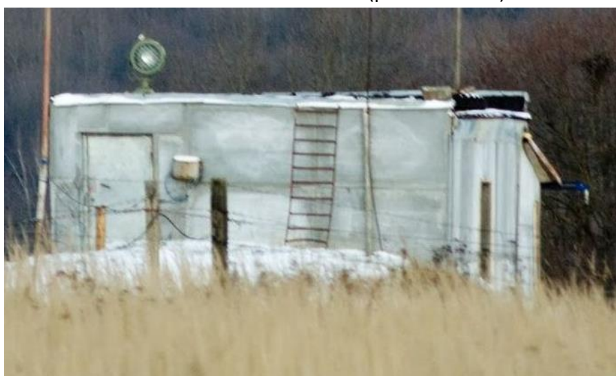
14.04.2010 Reflektor na dachu radiolatarni.
