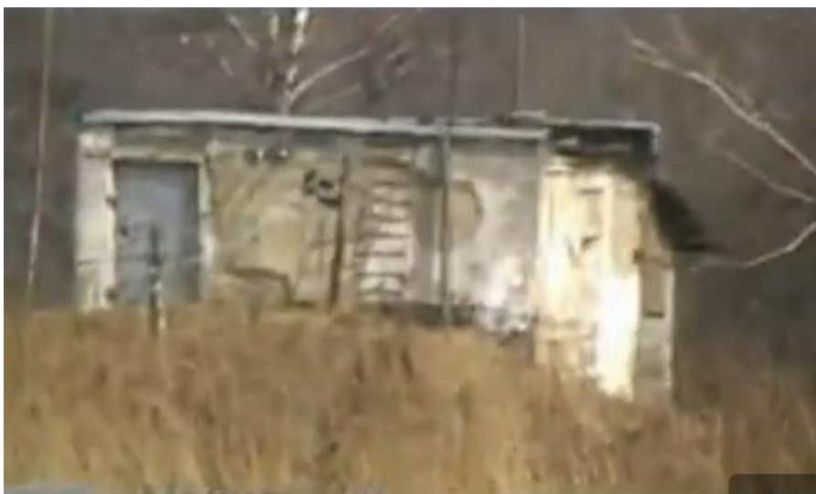
10.04.2010 Brak reflektora (po katastrofie).
